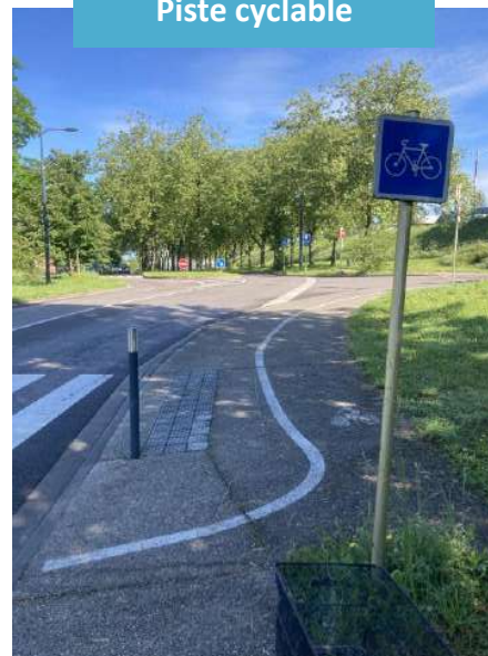
Piste cyclable boulevard Pierre Marizier à Bar-le-Duc (Source : visite terrain)
