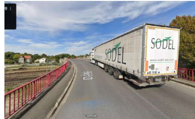
Pont menant à la gare de Revigny-sur-Ornain (Source: GoogleStreetView)
