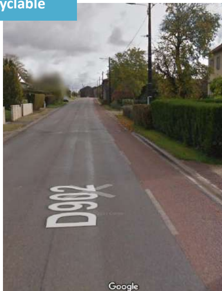
Bande cyclable rue du Général Porson à Laheycourt (Source : GoogleStreetView)
