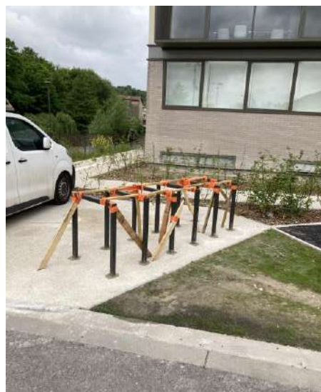
Arceaux en cours de construction près du marché
